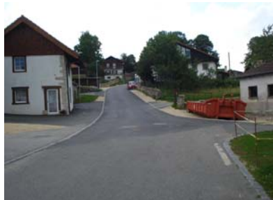
Rue des Rochets après les travaux
