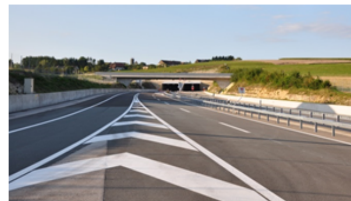
A16 jonction et tunnel de Bure. RWB a développé l'expertise issue de toutes ses compétences afin de relever un des plus grands défis de son histoire depuis sa création en 1938 : une intégration globale réussie de l'autoroute A16 dans la RCJU.
