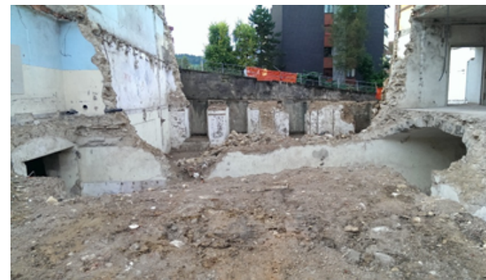
Site d'Onivia à Porrentruy : démolition d'une partie bâtiment pour réaliser des travaux de sondage afin de cartographier le site pollué par des déchets industriels.
