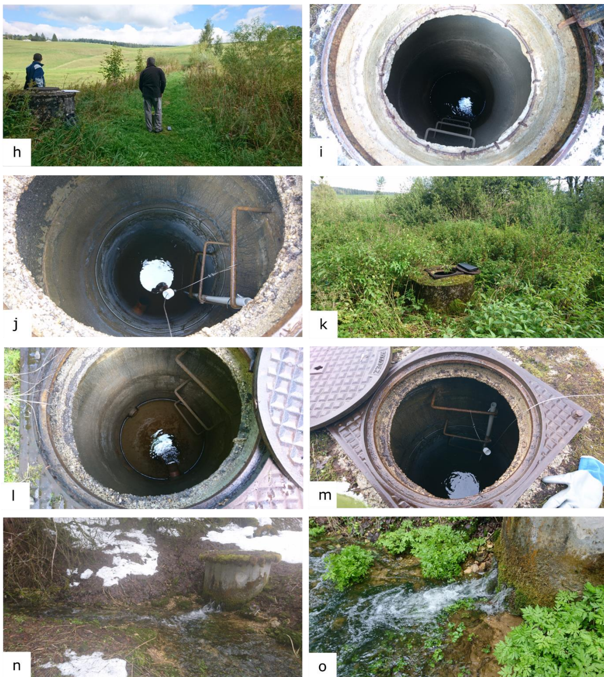
Annexe 4 : Photos des captages et systèmes de surveillance des sources. h) Chambre de captage de la Combe Nord, i) Chambre de captage de la Combe Nord en période d'étiage avec le tuyau des drains à l'air, j) Chambre de captage de la Combe Nord en hautes eaux avec les drains submergés, k) Chambre de captage de la Combe Centre, l) Chambre de captage de la Combe Centre en période d'étiage avec le tuyau des drains à l'air, m) Chambre de captage de la Combe Centre en hautes eaux avec les drains submergés, n) A droite chambre de captage de la Combe Sud et à gauche source temporaire de la Combe Sud, o) Trop-plein actif et fuite du captage de la Combe Sud.
