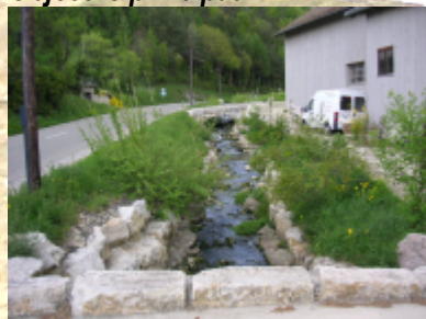
Tronçon mis à ciel ouvert
