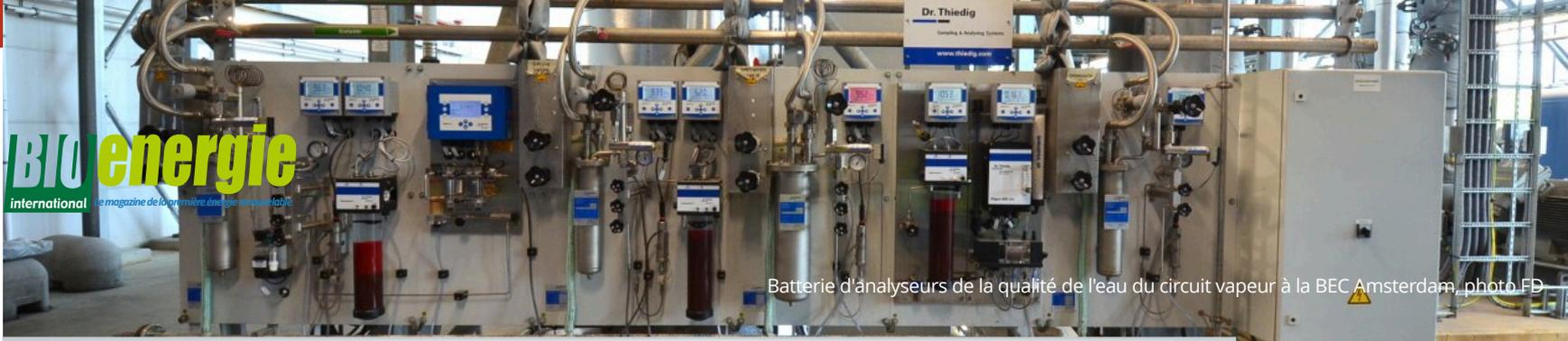
Batterie d'analyseurs de la qualité de l'eau du circuit vapeur à la BEC Amsterdam, photo FD
