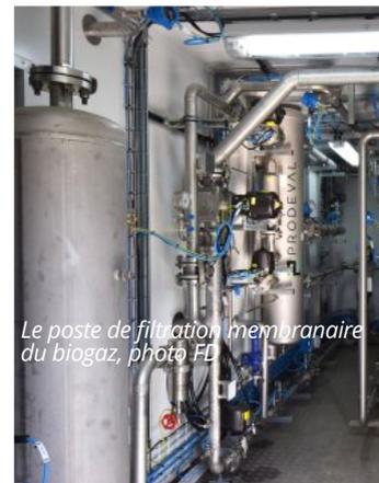
Le poste de filtration membranaire du biogaz, photo FD
